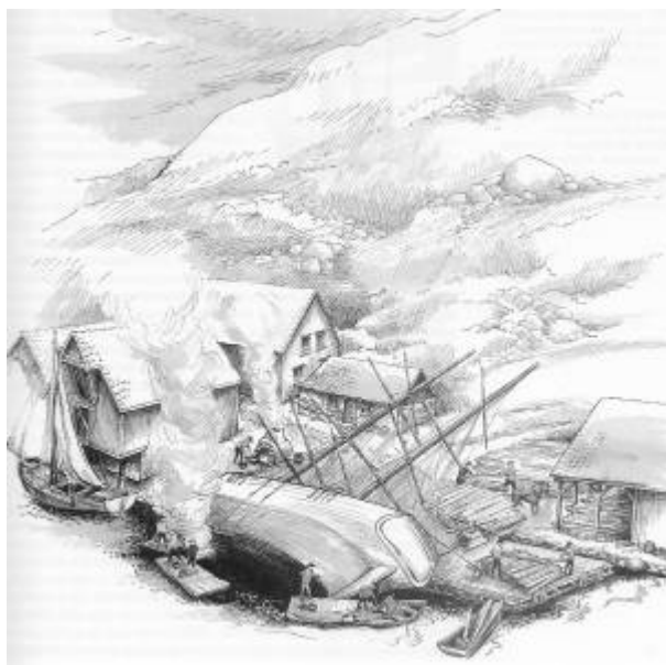
Livet på Bradbenken. Tegning: Reidun Lædre
