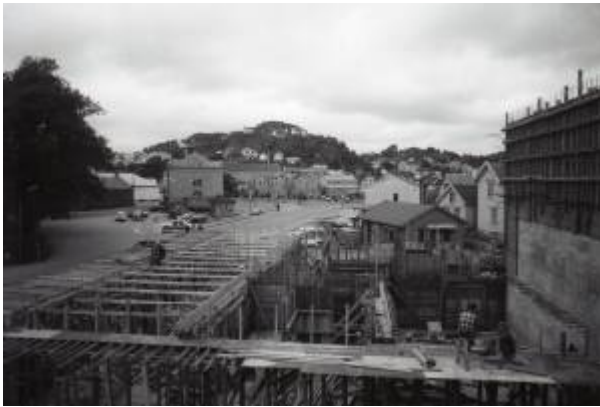
Torvgården under bygging - mai 1964. Foto: Fotohuset/DF
